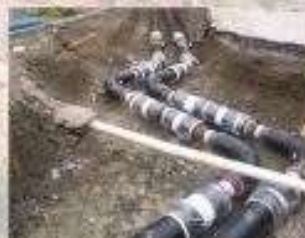
PARTICOLARE COSTRUTTIVO VALVOLA DI INTERCETTAZIONE A SFERA PREISOLATA
