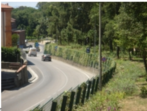
Progettazione e direzione lavori Giardino Storico di villa Rospigliosi (coprogettista e codirettore dei lavori, Lamporecchio (Pt)
